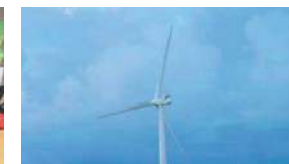
Un parc de sept éoliennes en bordure du sud Vienne ?
